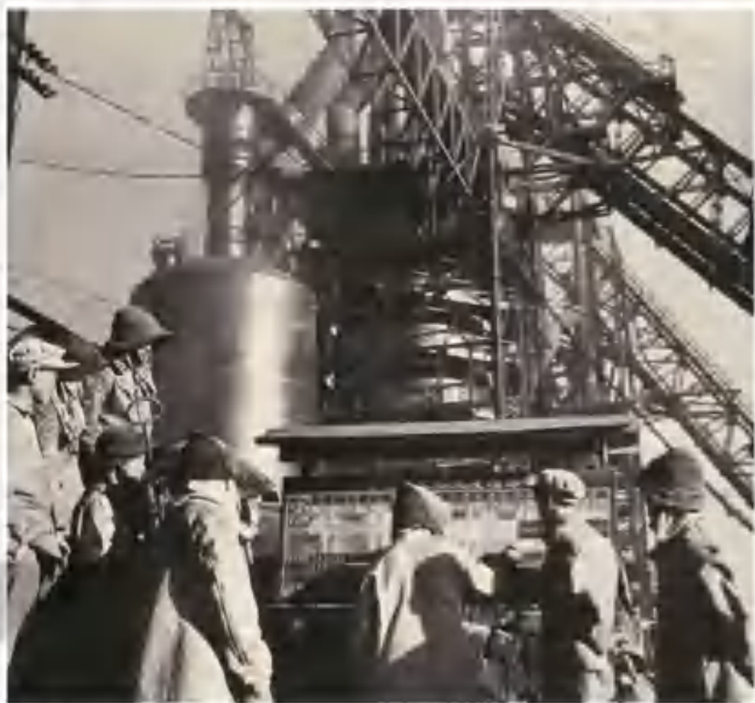
建设中的鞍山钢铁公司
