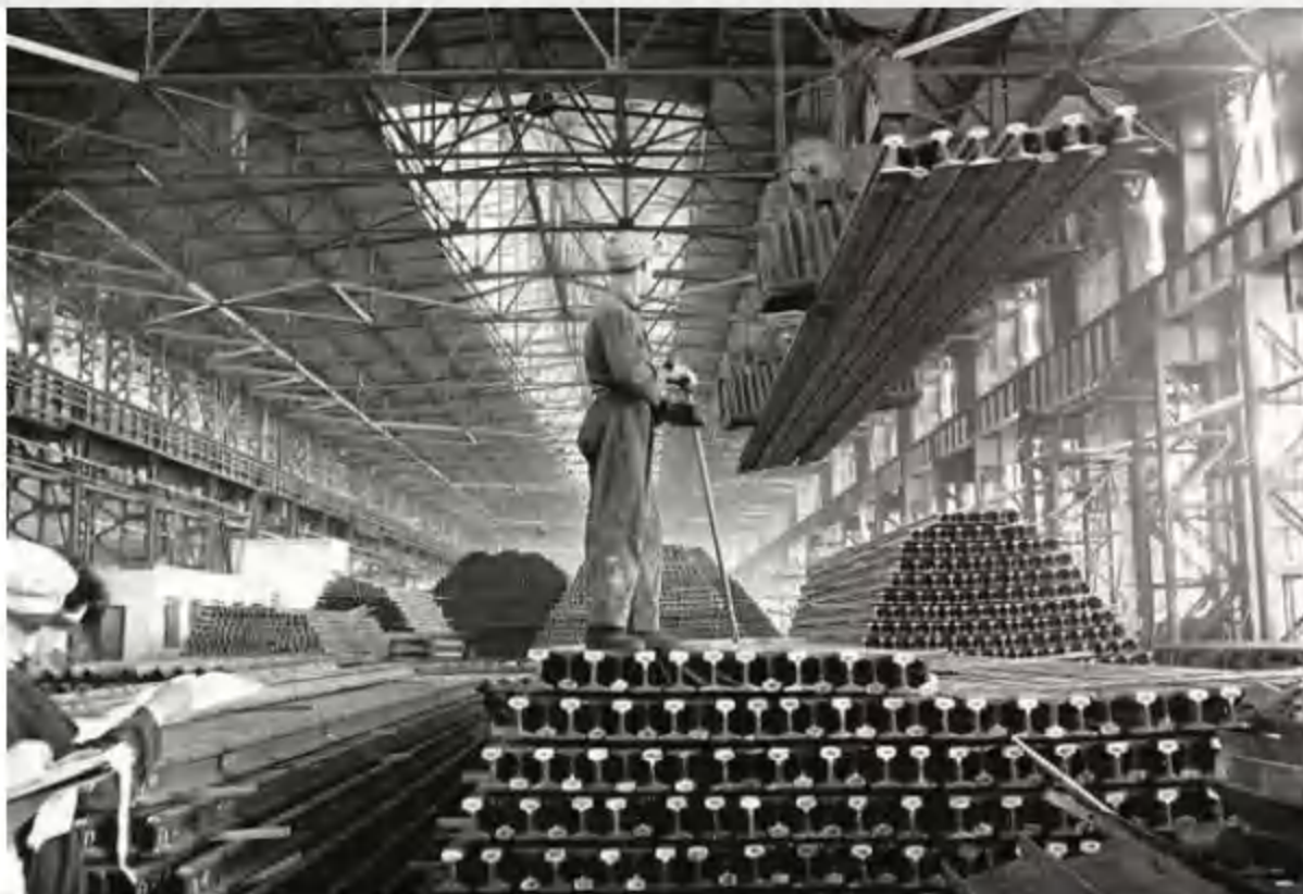
“一五”期间，鞍钢兴建的第一座大型轧钢厂生产能力迅速超过设计标准
