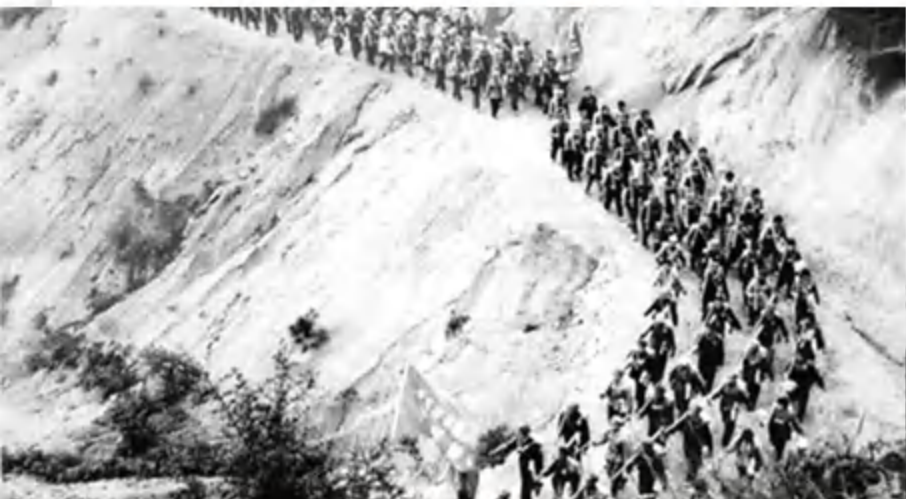
1958年成昆铁路正式开工
